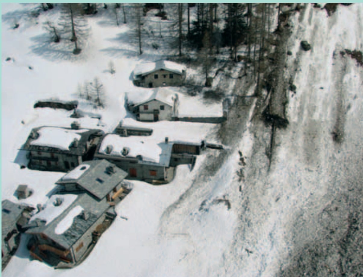
■ Ripresa aerea dell'abitato di Mayencet: la valanga ha lambito le case e danneggiato il bosco, sradicando vari larici.
