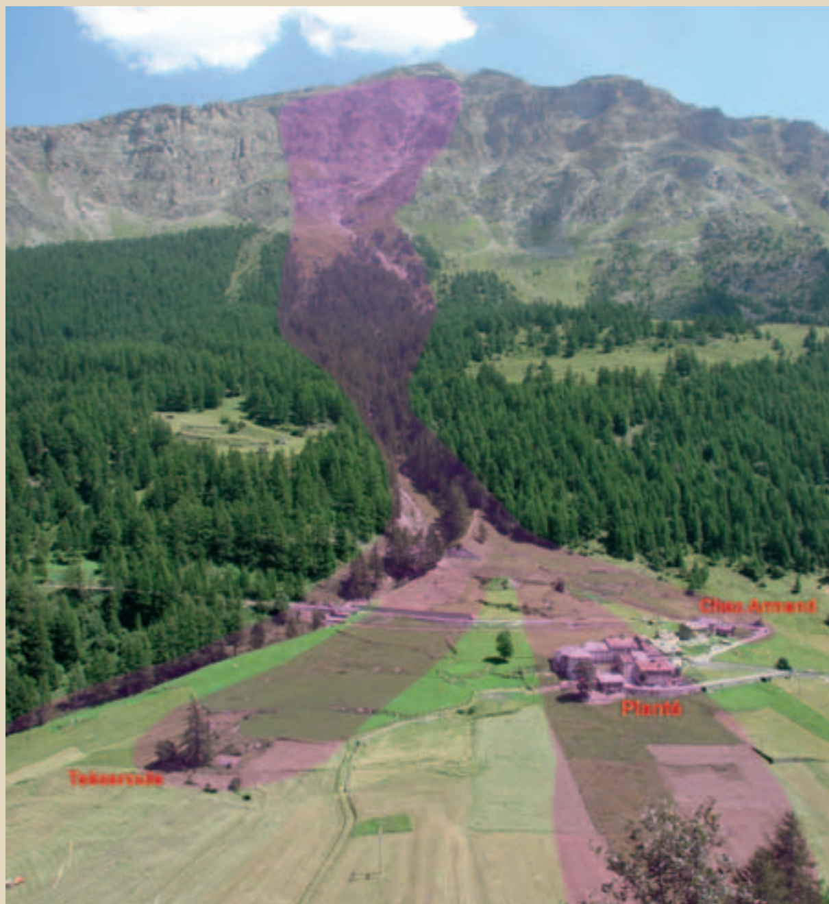
■ Fig. 6.1.3 - Vista generale del sito valanghivo, dalle Cingles de Tos ai prati della conoide del Torrent de Ramouà. In violetto le zone interessate dai diversi eventi valanghivi del passato.
