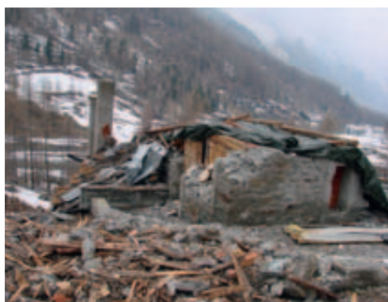
■ Uno chalet e una casa in muratura compromessi dal passaggio della valanga.
