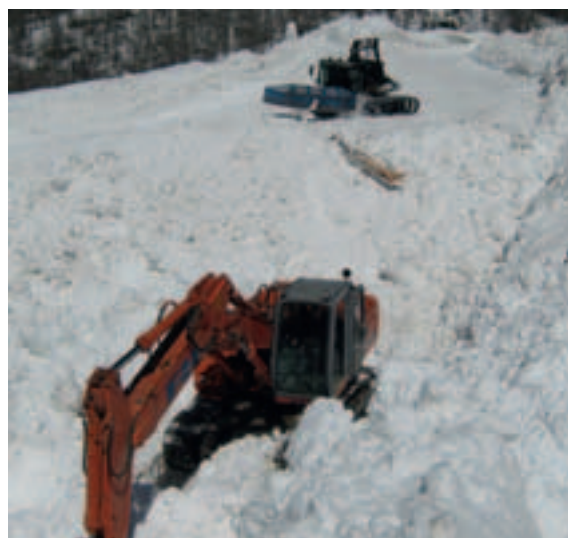
■ Rimodellamento della neve depositata dalle valanghe precedenti sul conoide di Varail de Bounitzon al fine di proteggere da nuovi eventi l'abitato di Gattinéry e la S.R. n. 44 della Valle del Lys nel tratto compreso tra il km 18+300 ed il km 19+000 (foto Stazione forestale di Gaby).
