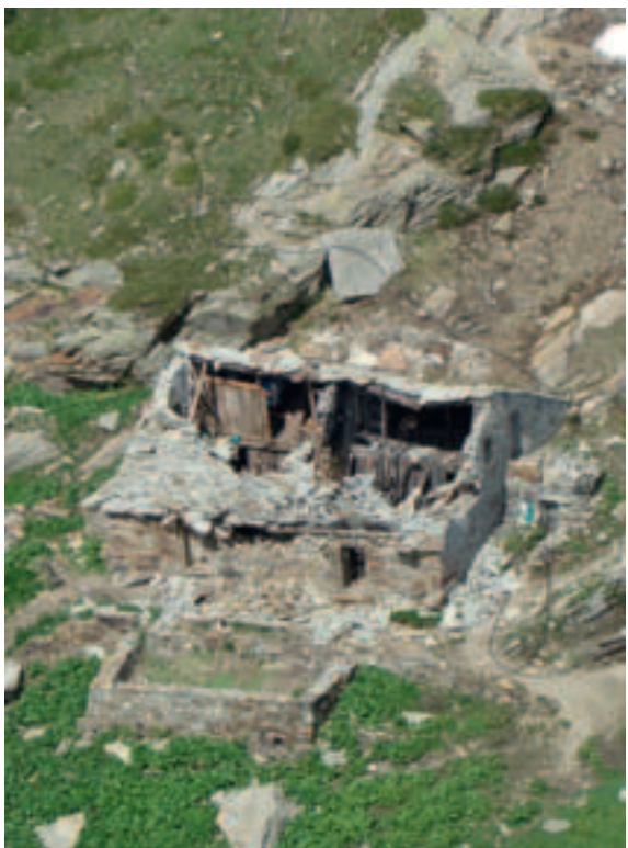
■ Cedimento della copertura della baita dell'alpe Rollumattu (2126 m), Vallone di San Grato - Issime.
