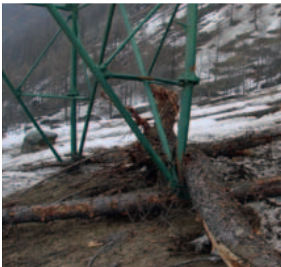
■ Un traliccio dell'alta tensione seriamente danneggiato dall'impatto dei numerosi alberi proiettati a valle dalla valanga di La Frange - Valsavarenche.
