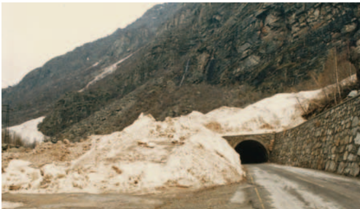
Nell'aprile 1986 la valanga di Varail de Bounitzon percorre l'intero conoide e si arresta nel torrente Lys ; l'accumulo occlude l'ingresso sud dell'omonima galleria paravalanghe. Sullo sfondo è visibile la valanga detta Varail de Valvertza (foto maggio 1986)
