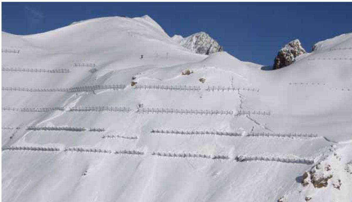
Particolare dell'area di distacco dell'evento di lunedì 1 marzo 2010 nei punti in cui la linea di frattura interseca le reti fermaneve. Al centro, in secondo piano è visibile la stazione automatica denominata "Lavanchers", posta a 2850 m di quota e completa dei sensori necessari al telerilevamento dei parametri nivometeorologici.
