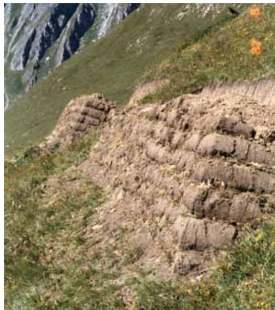
■ Particolari costruttivi dei gradoni. La funzione dell'opera è quella di ridurre l'omogeneità del pendio, rendendo meno probabile il distacco di ampi lastroni; la sua efficacia viene, però, meno quando si accumulano al suolo ingenti quantitativi di neve (foto Stazione forestale di Pré-Saint-Didier).
