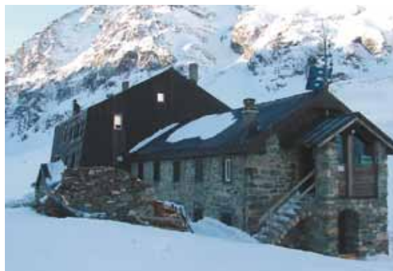
■ Vista delle facciate nord e est del rifugio non danneggiate dalla valanga.
