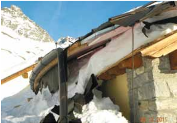
■ Particolare dei danni causati dall'impatto del flusso valanghivo sulla falda ovest del corpo del fabbricato: è evidente lo sradicamento del manto di protezione in lamiera, dei pannelli di isolamento, del tavolato e della grondaia.
