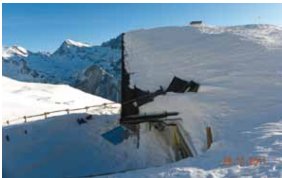
■ Visione d'insieme dei danni causati dall'interferenza valanghiva con il lato est della parte posta più a nord del rifugio. Si può notare la presenza di alcuni lembi di lamiera divelta sepolti dal deposito denso.
