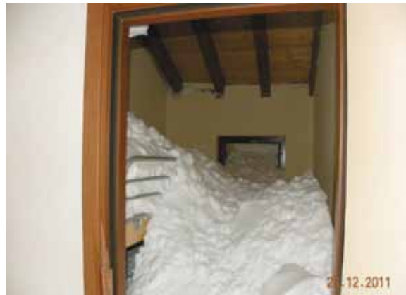
■ Deposito di neve asciutta fortemente compattata all'interno di una delle camere del rifugio. Lo scatto fotografico mette in evidenza l'invasione da parte del flusso valanghivo dei locali interni quali camere, corridoi e servizi igienici con conseguenti danni anche agli arredi. L'immagine mostra inoltre lo sfondamento dei serramenti posti sul lato ovest della parte sud del fabbricato.
