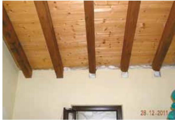
■ Dall'interno del fabbricato è possibile osservare il sollevamento della falda ovest da parte del flusso valanghivo con lo sradicamento di alcuni puntoni dalle proprie sedi murarie e la rotazione di altri con conseguente fessurazione dei tamponamenti.
