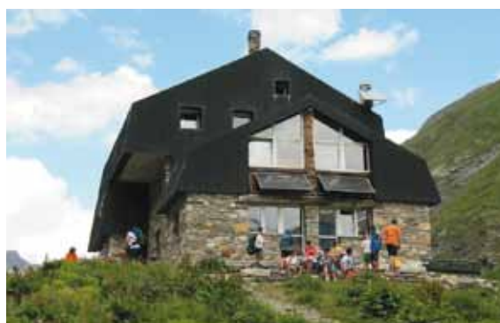
■ Vista della facciata sud del rifugio prima che fosse danneggiata dalla valanga ( http://it.wikipedia.org ).
