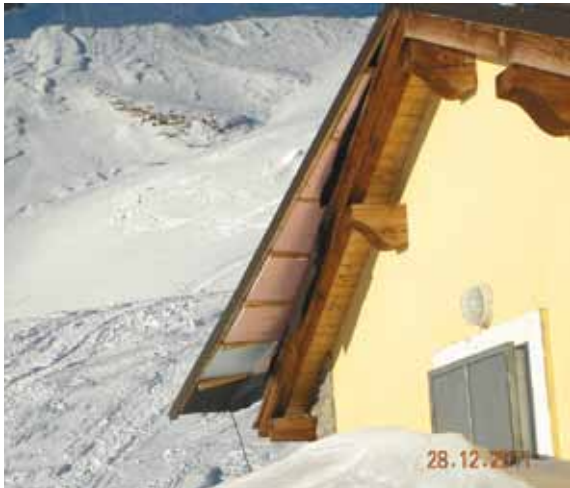
■ Particolare dei danni causati dall'impatto del flusso valanghivo con la falda ovest della parte meridionale del rifugio. Da notare come l'impatto abbia indotto una traslazione verso l'alto e verso valle della falda causando lo sradicamento della copertura in lamiera e dell'isolamento.
