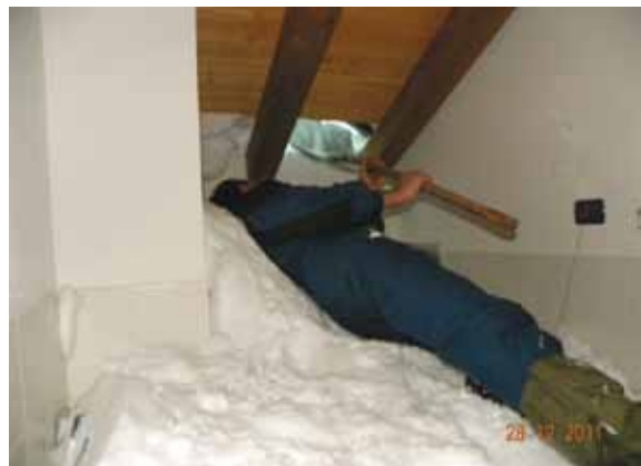
■ Operazioni di sgombero neve deposta dal flusso denso all'interno del rifugio.
