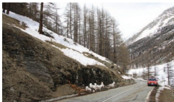
■ 12 aprile, sono ancora visibili i resti della valanga 13-075 detta Ovest Pessey C scesa il giorno prima. La strada è stata ripulita da un mezzo pesante e le temperature primaverili aiutano a fondere velocemente i rimasugli dell'accumulo posti ai lati della sede stradale.
