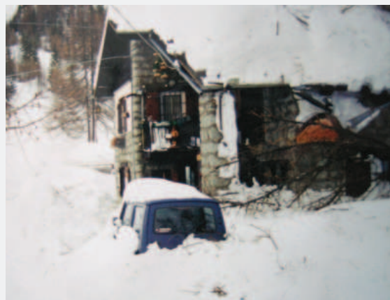
■ Una abitazione di Planpinceux danneggiata dalla caduta sul tetto di alcuni larici sradicati dall'impatto della valanga 18-030 (foto E. Bonora).
