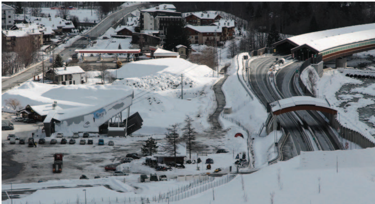
■ Lo scatto fotografico riprende buona parte dell'area interessata dall'accumulo della valanga. I segni più evidenti del passaggio dell'aerosol rimangono ancora visibili dopo alcuni giorni sulla parete ovest della stazione di partenza della funivia della Val Veny ancora intonacata.
