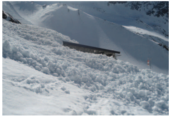
■ 17 aprile 2013: il deposito della valanga densa ed umida sul lato ovest del rifugio Aosta. La distanza dall'edificio ci indica l'importante ampiezza del deposito, nonché il suo volume. Ben si nota la funzione del tetto a falda singola di continuità con il pendio (foto M. Piffari).
