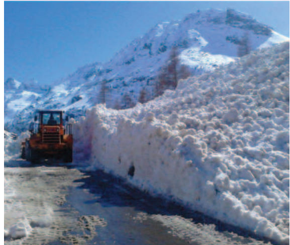
■ Domenica 14 aprile: mezzo pesante durante le fasi di ripulitura della strada. Si noti come l'accumulo sia costituito prevalentemente da neve molto pesante, pallottolare fortemente inumidita (foto CLV Valsavarenche).
