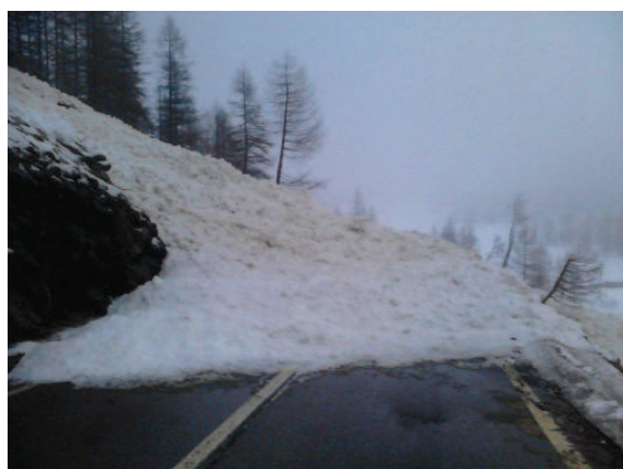
■ 11 aprile, anche la valanga 13-080 detta Ovest Pessey B raggiunge la strada regionale: risulta essere la colata di neve umida più grande che interessa la strada nel corso della giornata (foto CLV Valsavarenche).
