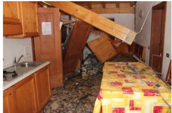
■ Fig. 4.43: la cucina del bivacco di Promoud a seguito dell'evento valanghivo del febbraio 2014. Da notare la posizione della trave di colmo.
