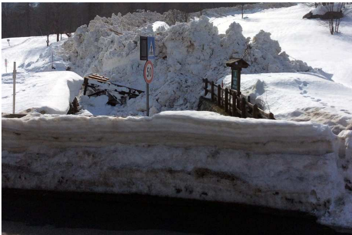
■ Fig. 4.84: particolare del ponte di legno travolto e trascinato a valle dalla massa nevosa; l'accumulo è composto da neve molto umida e carica di detriti, caratteristiche tipiche delle valanghe primaverili (foto CLV Gressoney).
