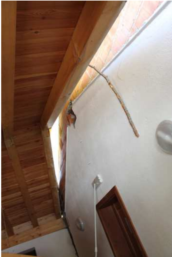
■ Fig. 4.45: particolare dello scollamento del tetto del bivacco dal corpo centrale e della scomparsa della trave di colmo. Lo scatto ben evidenzia la rototraslazione imposta dalla valanga al tetto.
