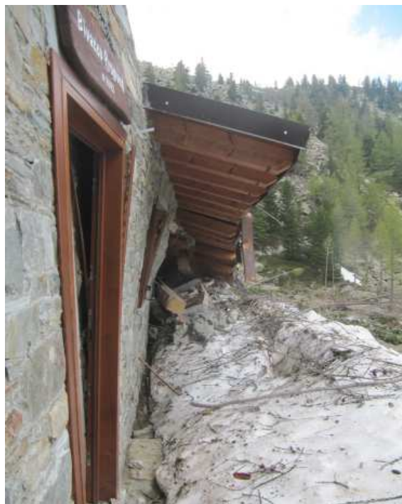
■ Fig. 4.48: ben si nota il ribaltamento del rivestimento in pietra anche del corpo centrale. Da questa angolazione sembra che il tetto sia ancora indenne (Foto E. Lumignon).
