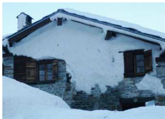
■ Fig. 4.58: una delle case di Proussaz intonacate maggiormente dall'aerosol della valanga (foto Corpo forestale della Valle d'Aosta).
