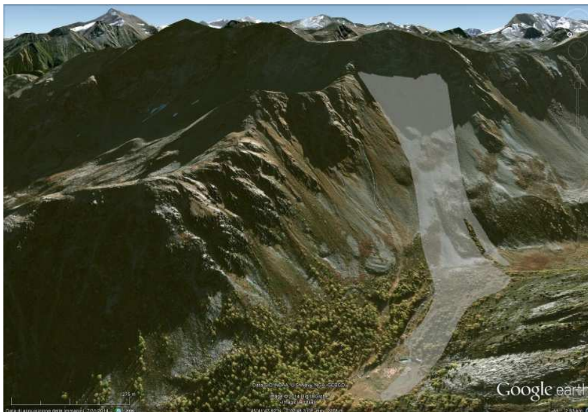
■ Fig. 4.49: vista 3D del vallone di Lantaney e della valanga nel suo complesso, dalla zona di distacco all'accumulo. Sono visibili gli edifici di recente edificazione e, al margine sinistro del prato, il grosso masso dove era collocata la vecchia casera (vedi Figg. 4.40 e 4.41).
