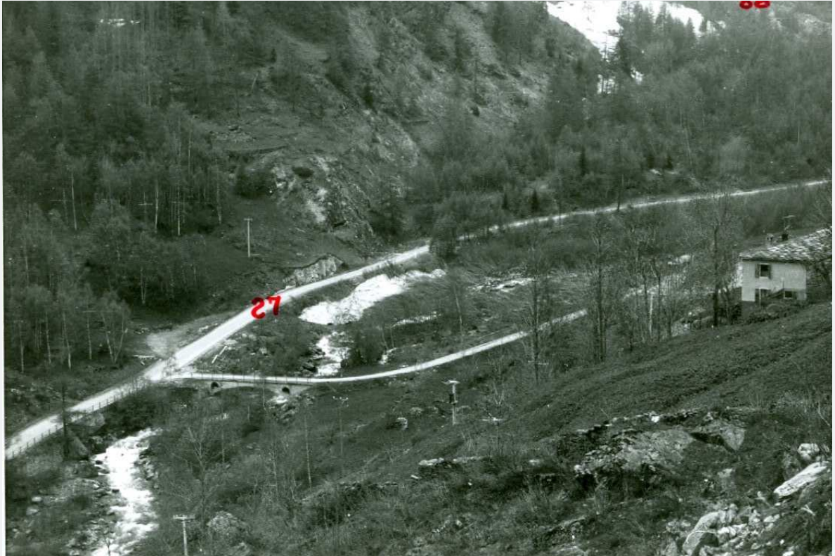
■ Fig. 4.63: primavera 1972. Alla fine della stagione invernale è ancora evidente il passaggio della valanga, che aveva raggiunto il letto della Doire (dove è ancora presente della neve da valanga facente parte dell'accumulo) e la strada regionale, molto probabilmente ostruendola.
