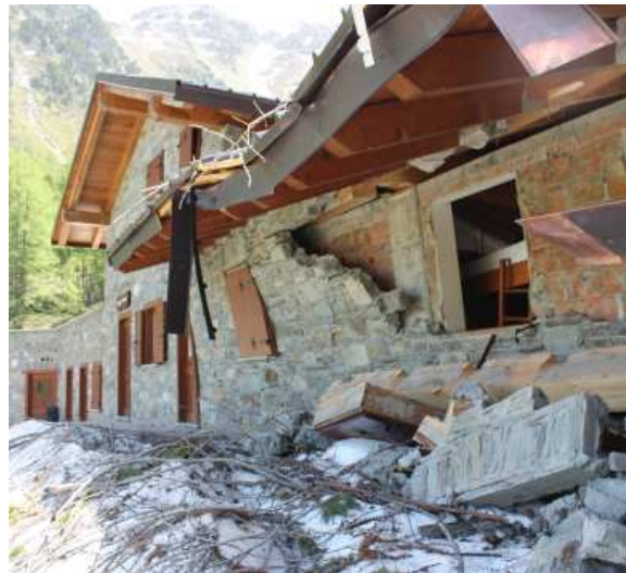
■ Fig. 4.46: in giugno 2014 si può ancora notare il deposito valanghivo a valle dell'alpe di Promoud. Da notare il ribaltamento del rivestimento in pietra, causato dallo spostamento del tetto verso valle. Al centro, il telaio della seconda finestra del bivacco.
