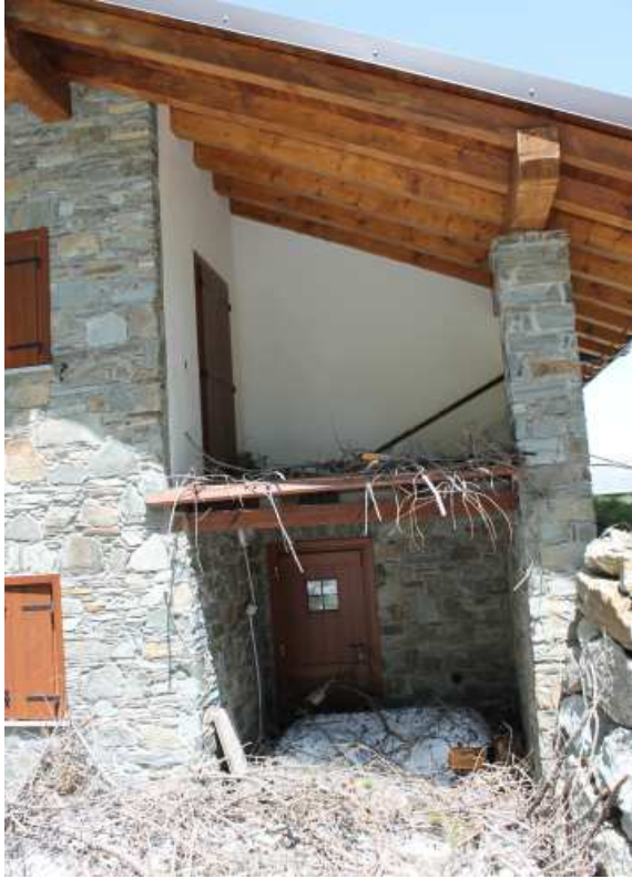
■ Fig. 4.42: particolare del lato di monte del corpo centrale dell'alpeggio di Promoud. In giugno si notano la ramaglia trasportata anche sul terrazzo al primo piano e il deposito nevoso, non ancora completamente fuso, al piano terra.
