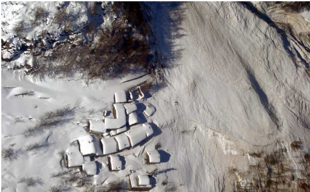
■ Fig. 4.56: segni di erosione esercitata dalla valanga sui pendii limitrofi a Courthoud, evidenti se confrontati con l'aspetto del manto nevoso all'estrema sinistra, che risulta più integro e privo di scabrosità. Anche le case poste sul margine destro della frazione presentano sul tetto neve in parte rimescolata dal passaggio del veloce flusso.
