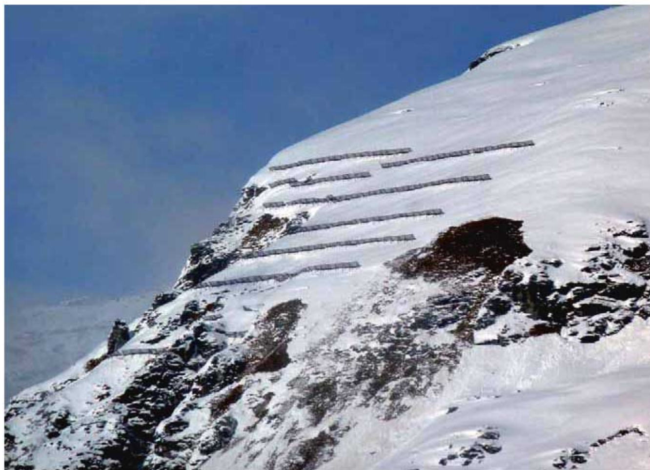
■ Fig. 4.7: evidente distacco di fondo verificatosi dalla parete sud della punta Telcio (Gressoney-La-Trinité), valanga 01-130 detta Tro-llocke. Grazie alla presenza delle opere parapalanghe denominate ponti da neve è possibile apprezzare lo spessore al distacco di circa 150 cm che comprende tutte le nevicate verificatesi fino al 12 novembre (foto M. Maggioni).
