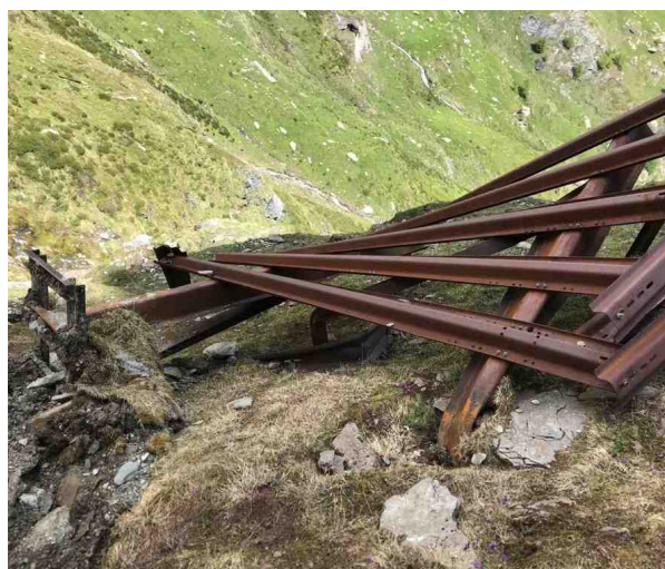
Figura 3.17: a luglio durante un sopralluogo della Commissione valanghe e dei tecnici dell'amministrazione regionale si documentano i danni alle strutture ferma neve. Nella foto si nota come il flusso della valanga 01-114 abbia divelto e in alcuni casi piegato alla base le putrelle dei ponti da neve (foto Commissione locale valanghe).
