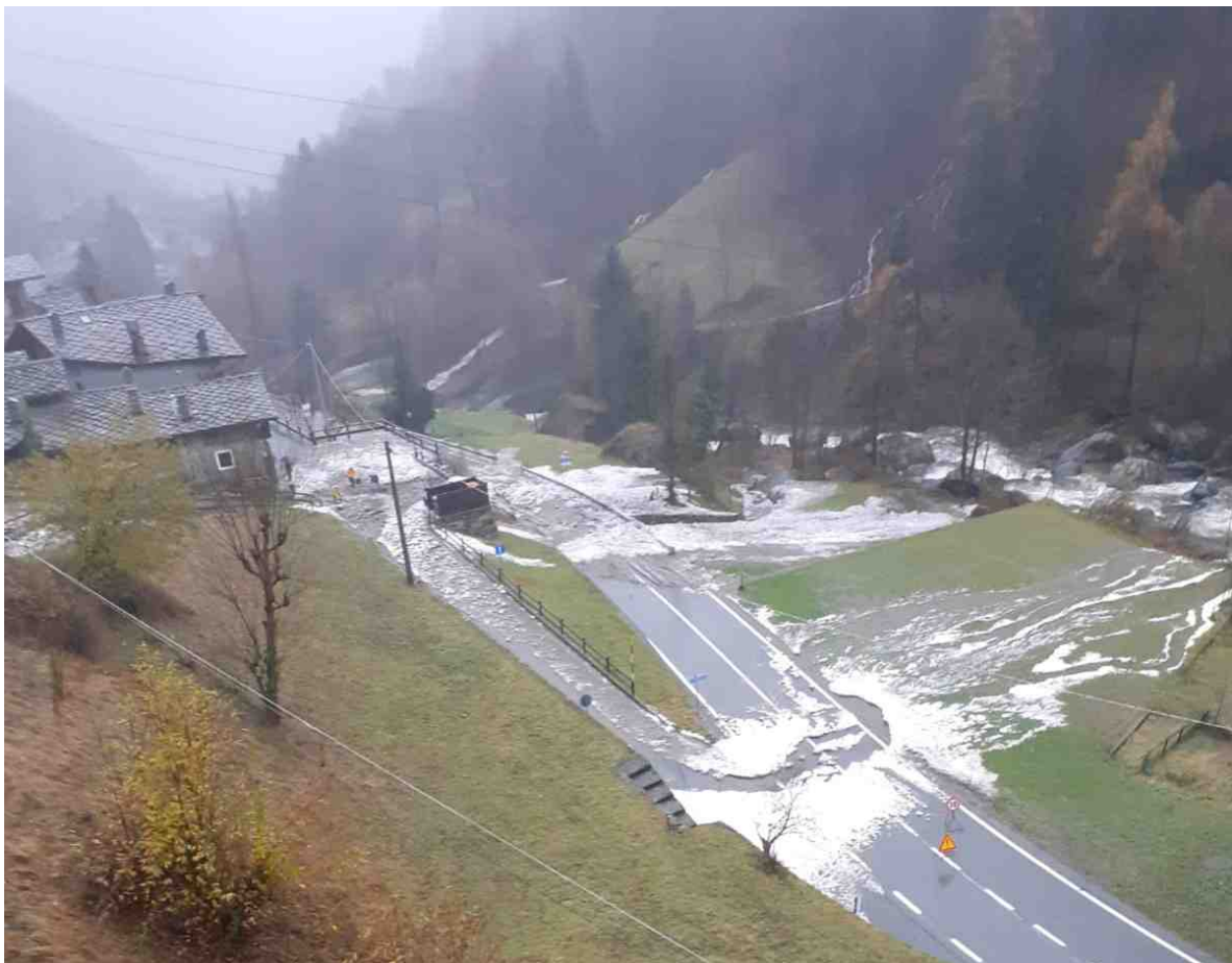
Figura 3.11: il 23 novembre le valanghe iniziano a raggiungere il fondovalle della Valle di Champorcher. Nello scatto fotografico si vede la colata di neve fradicia frammista a acqua nei pressi di Trambesère che invade la strada regionale nei pressi del limite comunale tra Pontboset e Champorcher (foto L. Pitet).
