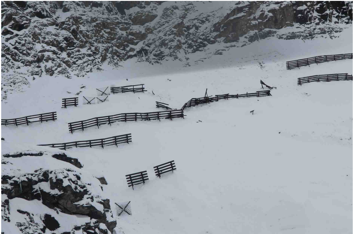
Figura 3.15: la valanga 01-114 prima di raggiungere il fondovalle e avvicinarsi all'abitato di Eselboden (Gressoney-La-Trinité) incontra lungo la sua strada i ponti da neve posizionati negli anno '80 a protezione dell'abitato. I danni alle strutture ovviamente sono ingenti e ben visibili nello scatto del 26 novembre.
