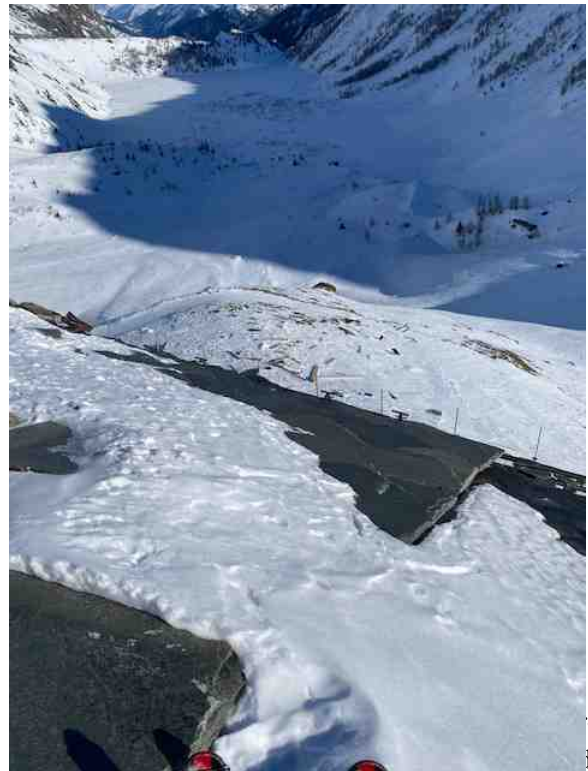
Figura 3.23: particolare dei pezzi del rifugio trasportati verso valle della valanga 19-055 lungo la dorsale della morena dove sorge il rifugio Elisabetta (foto Commissione locale valanghe).
