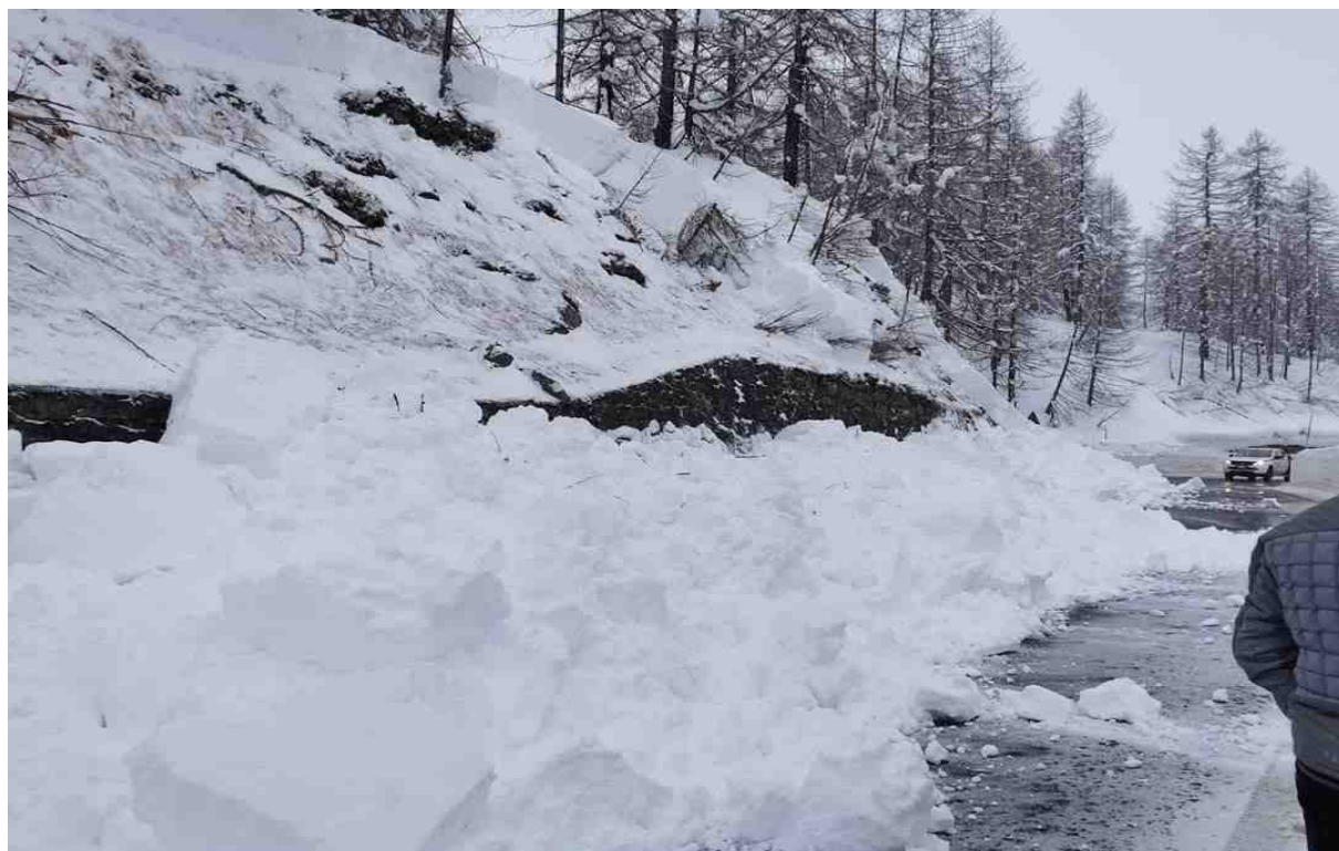
Fig. 4.17: distacco a monte della scarpata stradale su strada regionale n.46 che porta a Cervinia (Valtournenche), nei pressi del Lago Blu il 29 gennaio 2021. Vedi anche Fi. 5.43.
