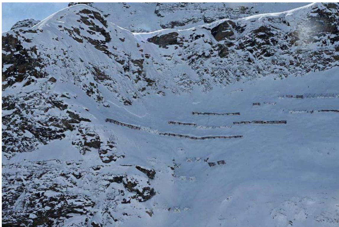
Figura 5.41: la valanga 01-114 di Testa Grigia (Gressoney-La-Trinité) del 3 marzo. Particolare del distacco lineare superficiale posto sia sopra che sotto le opere paravalanghe. Grazie alla loro azione l'area potenziale di distacco è stata decisamente ridimensionata, riducendo la magnitudo della valanga.
