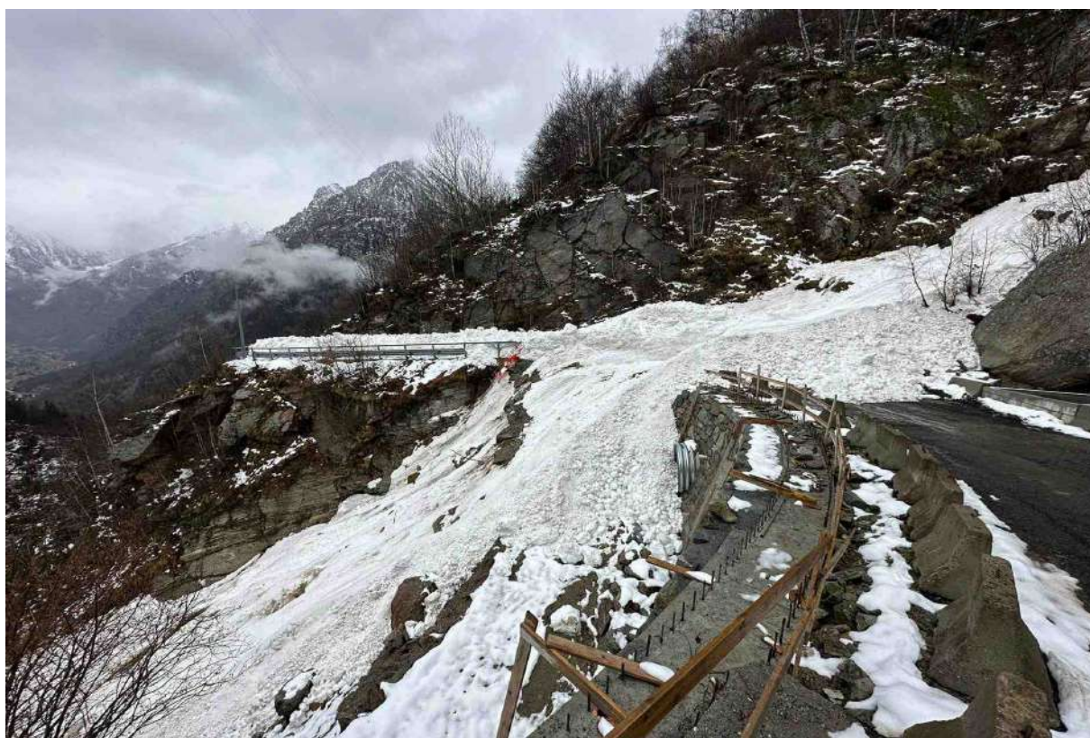
Fig. 4.18: 28/02/2024. Valanga 01-118 Kraka - Frinna che ha superato la strada comunale per la frazione di Niel nel Comune di Gaby.
