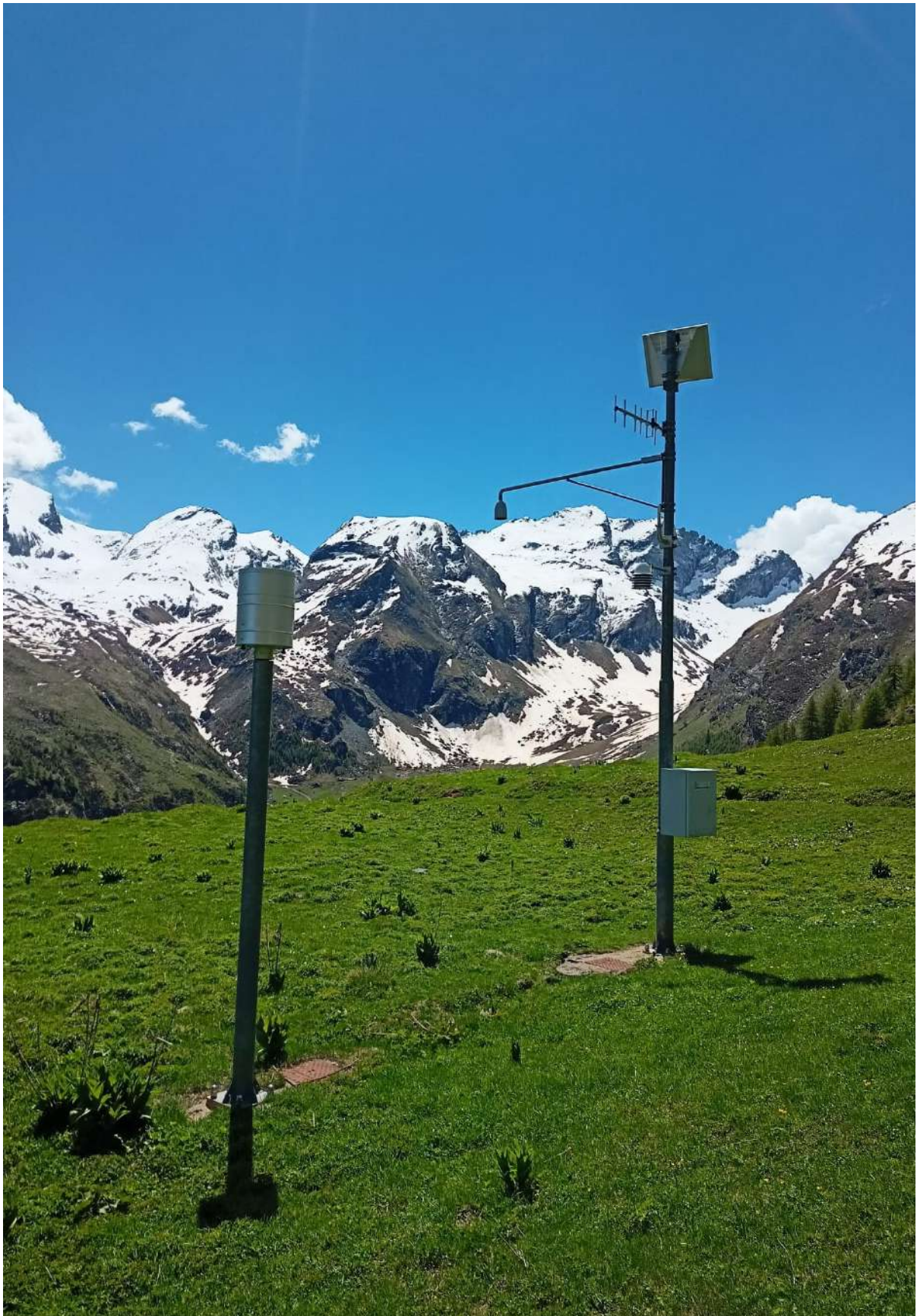
L'immagine ritrae la stazione meteo automatica posizionata in località Lavodilec a quota 2250 s.l.m. nel Comune di Fénis. Foto scattata dai tecnici di Fondazione Montagna sicura durante un sopralluogo primaverile per il censimento degli eventi valanghivi verificatisi nel corso della stagione nel vallone di Clavalité.
