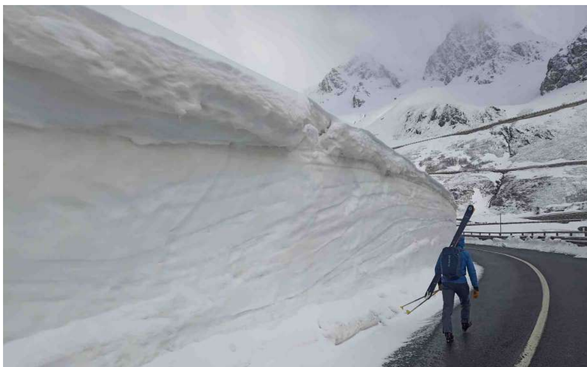
Fig. 4.27: 03/05/2024. Un rilevatore percorre un tratto della strada statale del Gran San Bernardo.
